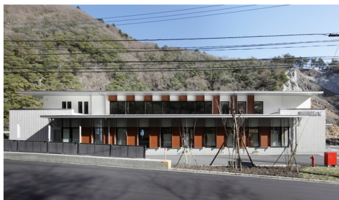
外観写真1: 県道側外観
