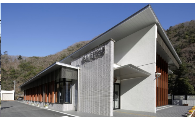
外観写真2: エントランス
