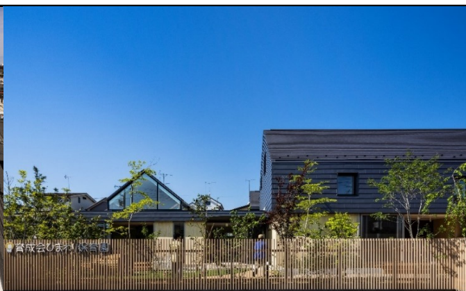
外観2 外部にも木材を使用し木材の温かみを内外に連続させた
