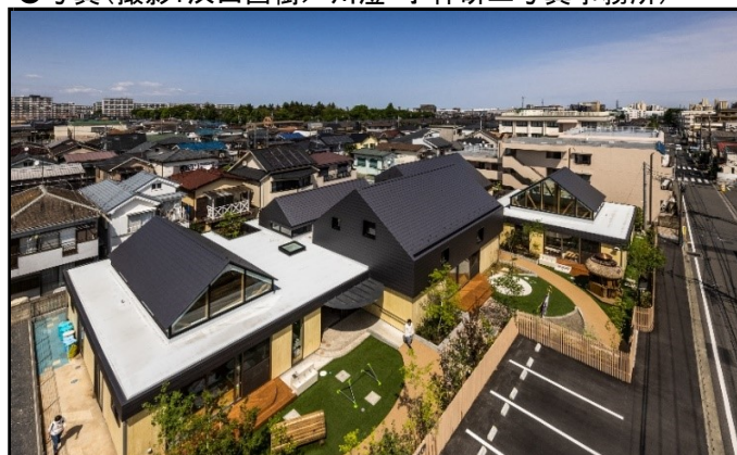
外観1 周囲の住宅スケールに溶け込むよう5つの家型を一般材を用いて分散配置
