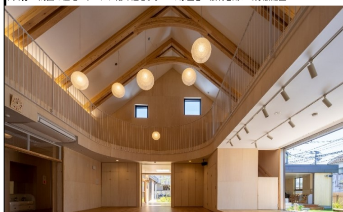
内観1 ホールは登り梁に湾曲集成材を用いた現しの燃え代設計で計画
