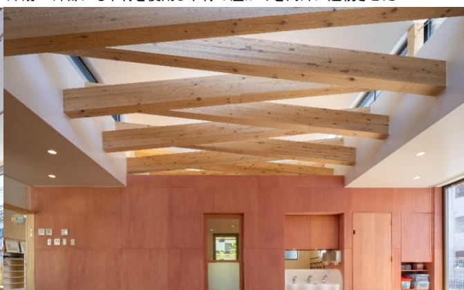
内観2 機能やスパンに合わせて架構を選択し45歳保育室は支点桁架構で計画
