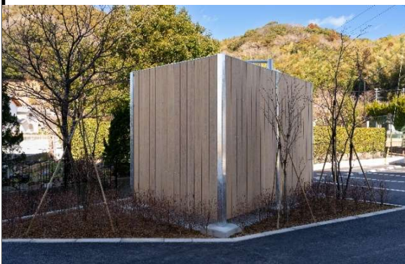
外観写真3: 受水槽
