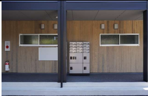
外観写真2: 1階共用廊下
