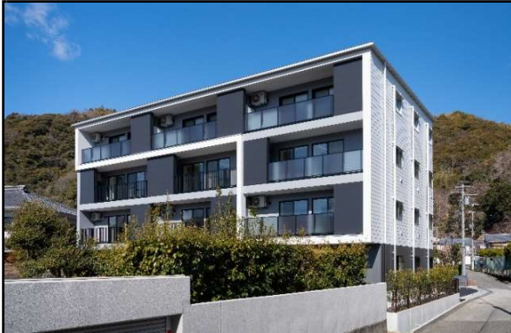
外観写真1: 正面外観
