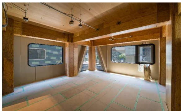
内観写真2(柱・梁にLVL耐火被覆を使用)
